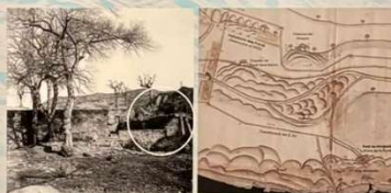
Mina de Mirabelle , cerrojo Mina de la Fort, andamios en las fuerzas al interior. Fuente: Departamento del Interior, Dirección de Minas, 1987.
