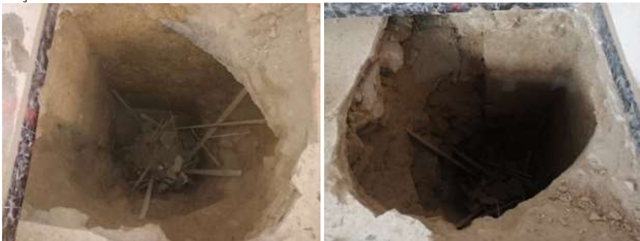
Imatges de la cala 2 de la botiga amb l'aparell dels murs que la delimita en pedra picada
