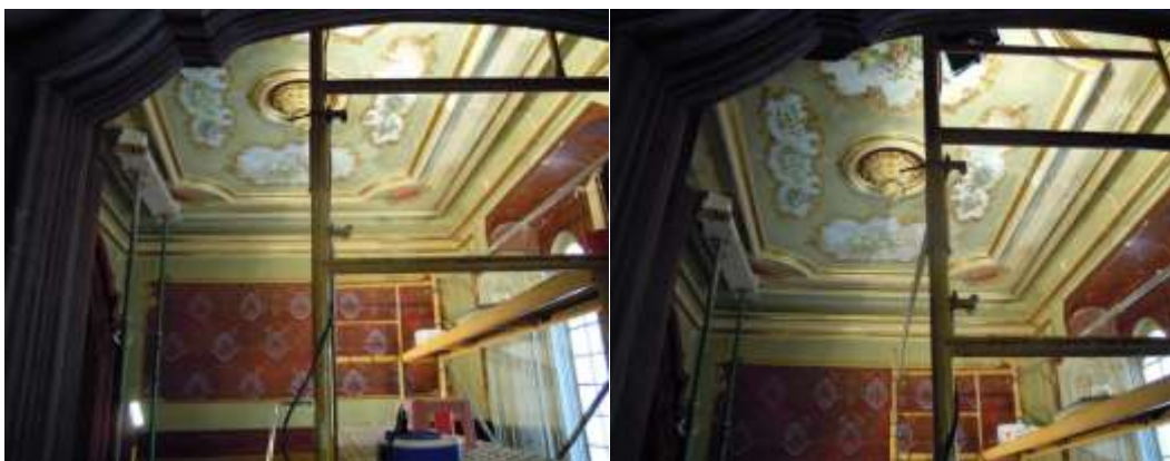
Imatges dels treballs de restauració realitzats el 2016. Imatges. P. Cascante 2016
