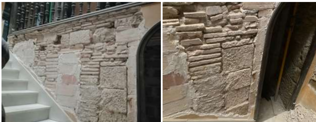
Detalls del parament del mur de tancament del celler amb algunes parts de pedra picada altres amb maó ceràmic, maçoneria i guix.
