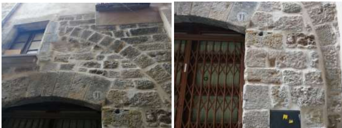
Imatges de la façana del carrer de Sant Josep de Calassanç i de la façana del Carrer Castell i detall de l'arc ogival aparegut en un dels laterals. Imatges. P. Cascante. Febrer de 2020
