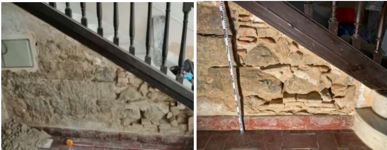
Detall del mur que sosté l'escala actual amb aparell de pedra picada de factura medieval
