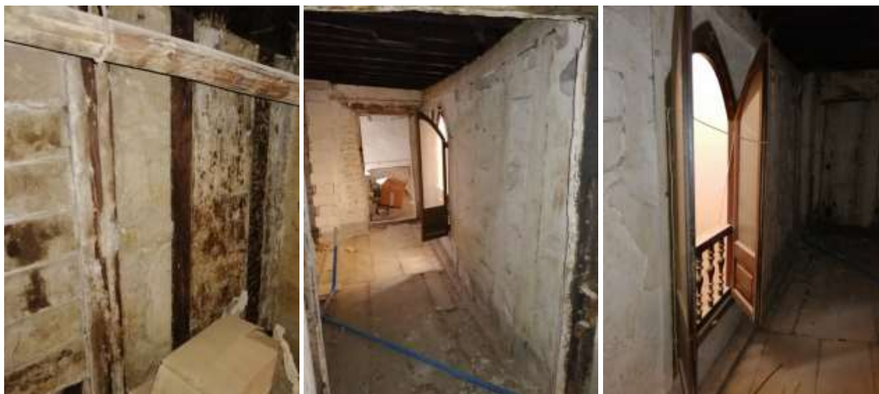
Imatges del parament que forma els envans interiors de la planta segona que miren al llanternó de l'escala. Noteu-ne la tipologia constructiva de l'entramat i tàpia (imatges P. Cascante, 2020)
