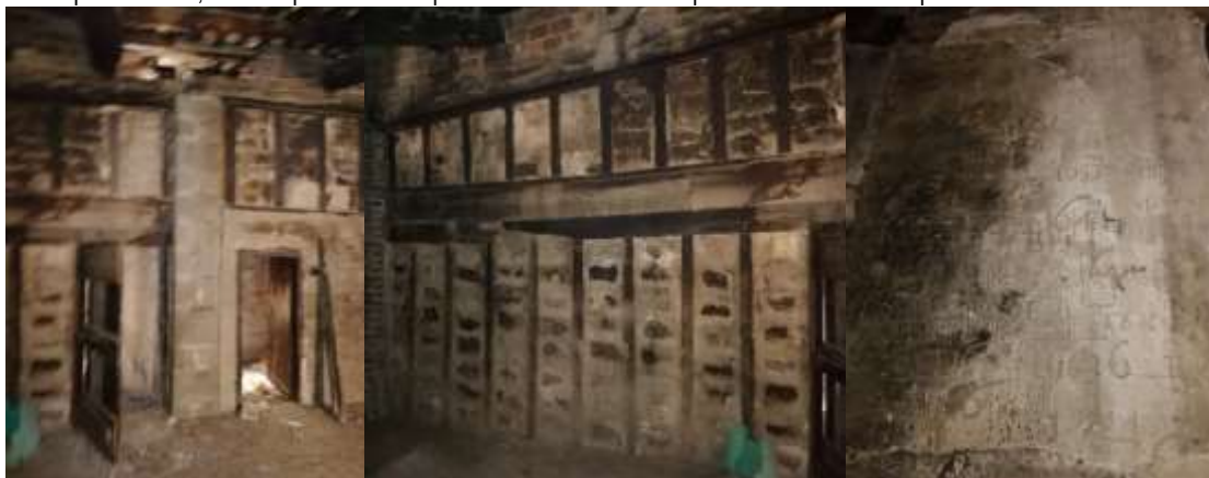
Detall dels paraments amb estructura d'entramat i grafiti de la planta segona o sota teulada
