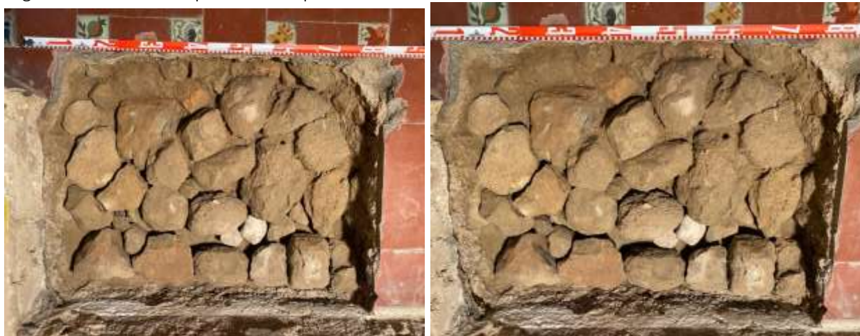
Detall de la cala feta a l'oest de la porta d'entrada amb el mateix paviment que la cala 1.
