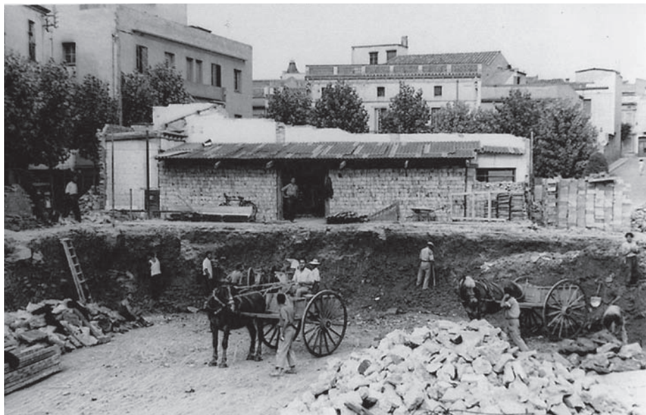
Feines de construcció del soterrani del Nou Mercat (1956). Autor: Josep Feliubadaló. Procedència: Arxiu Roset.
