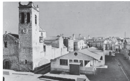
El Mercat Nou (1930-1956), un edifici tot cobert. Autor desconegut. Procedència: Arxiu Roset.
